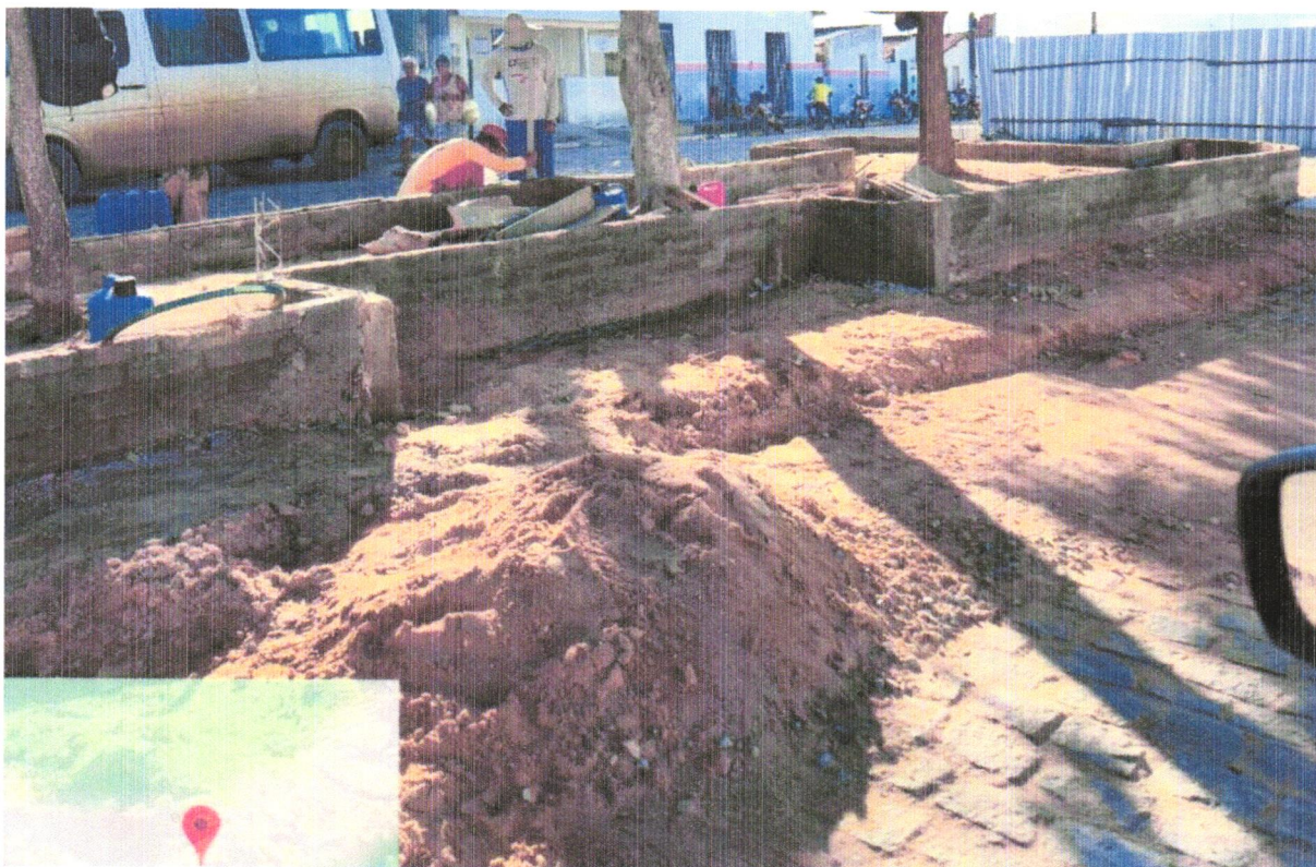
FOTO 02 - RETIRADA DE MEIO-FIO DNER / ECONOMICO COM EMPILHAMENTO E SEM BOTA FORA
