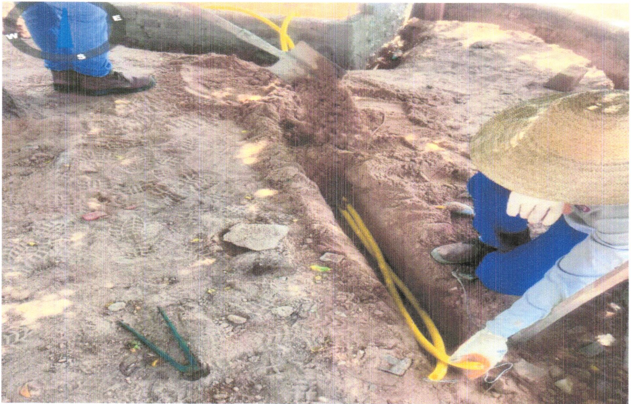
FOTO 20 - ELETRODUTO FLEXÍVEL CORRUGADO REFORÇADO, PVC, DN 20 MM (1/2"), PARA CIRCUITOS TERMINAIS, INSTALADO EM FORRO - FORNECIMENTO E INSTALAÇÃO.
