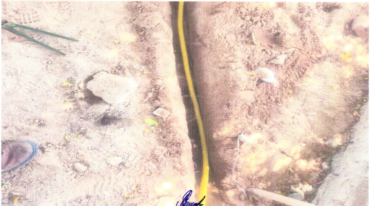
FOTO 20 - ELETRODUTO FLEXÍVEL CORRUGADO REFORÇADO, PVC, DN 20 MM (1/2"), PARA CIRCUITOS TERMINAIS, INSTALADO EM FORRO - FORNECIMENTO E INSTALAÇÃO.
