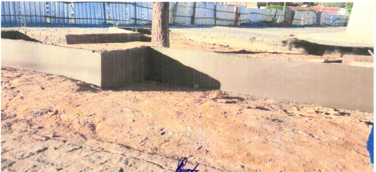
FOTO 12 - MASSA ÚNICA, PARA RECEBIMENTO DE PINTURA, EM ARGAMASSA TRAÇO 1:2:8, PREPARO MANUAL, APLICADA MANUALMENTE EM FACES INTERNAS DE PAREDES, ESPESSURA DE 10MM, COM EXECUÇÃO DE TALISCAS. AF_06/2014.
